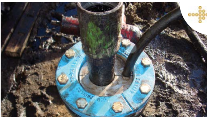
Cabeza de pozo terminada
